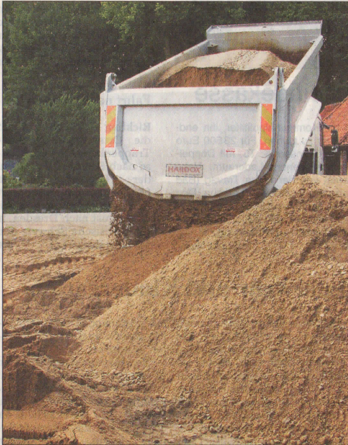
80 Kieslaster liefern am Winklersgang in Bad Segeberg ihre Ladung ab, um einen neuen Untergrund für den geplanten Boule-Platz zu schaffen.
