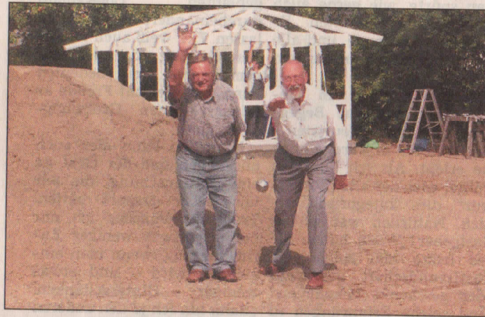
Vereinssprecher Jürgen Braune (rechts) und sein Club-Mitstreiter Manfred Ziesmann probten auf dem noch im Bau befindlichen Platz den Zielwurf. Der Glaspavillon als Aufenthaltsraum für die Boule-Spieler wurde gerade aufgebaut.
